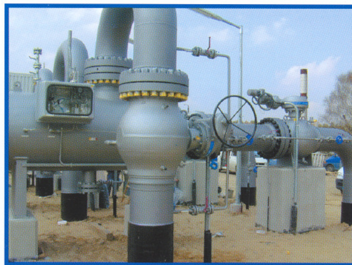
Шаровой кран “HKSF-W” на компрессорной станции
